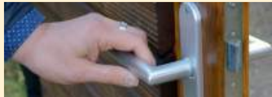
Wenn die Belattung auf dem Rahmen sitzt, lässt sich die Klinke oft nicht mit allen Fingern umfassen. Die Türen sind aber so leichtgängig, dass ein Druck mit den Fingerspitzen genügt.
