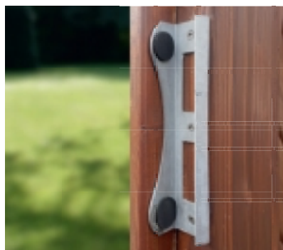
Einbau des Anschlagwinkels bei Toren Gehflügel DIN-links
