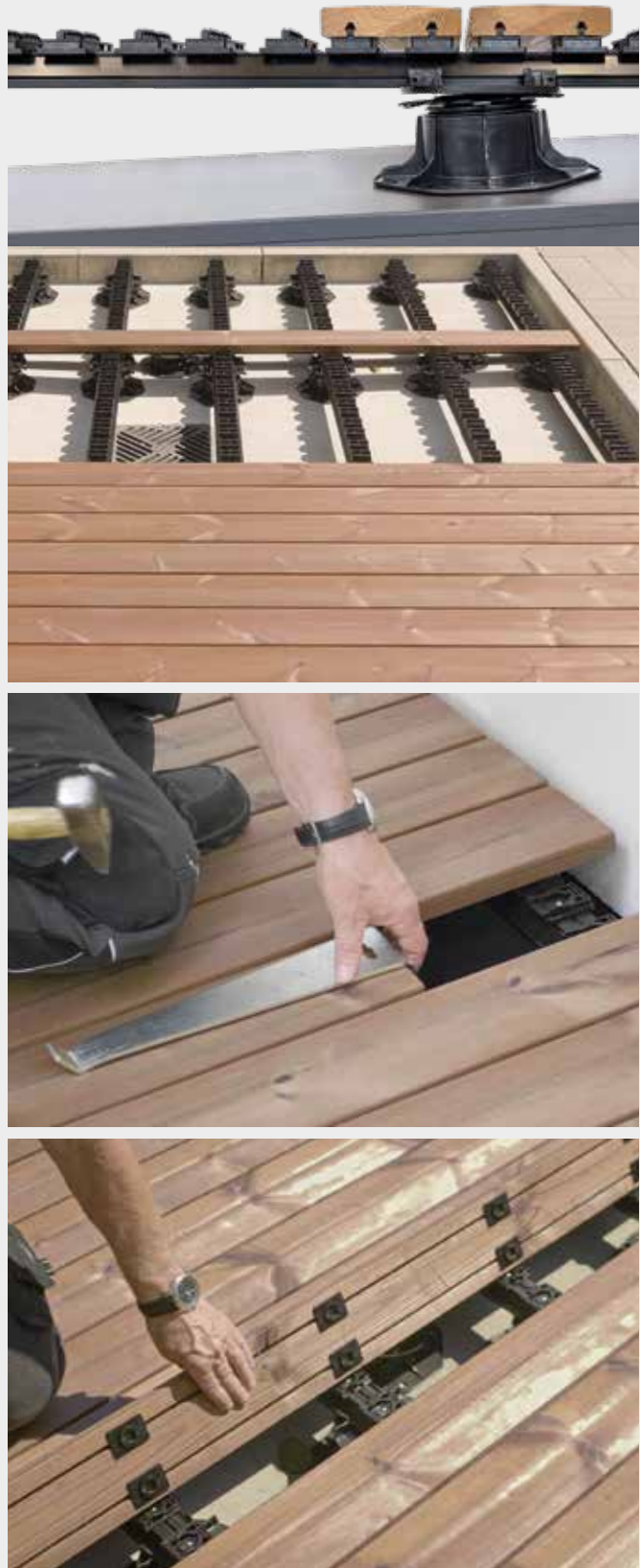
Einfacher Austausch einzelner Bretter
