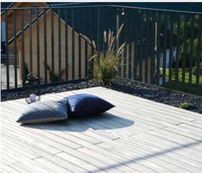
Abb.: unbehandelt, silbergraue Patina durch UV-Einstrahlung
