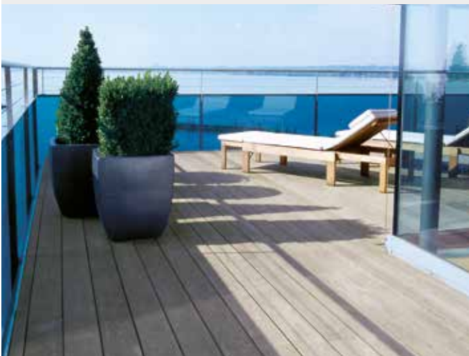
Abb.: unbehandelt, silbergraue Patina durch UV-Einstrahlung
